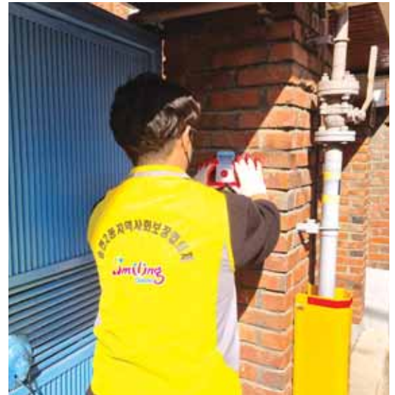
송현2동 무선초인등 설치
