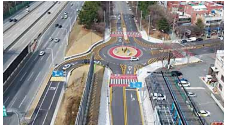
진출로 접속교차로 개선(진출로 추가설치 후)
