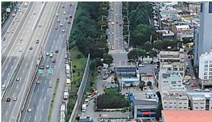
진출로 접속교차로 개선(진출로 추가설치 전)
